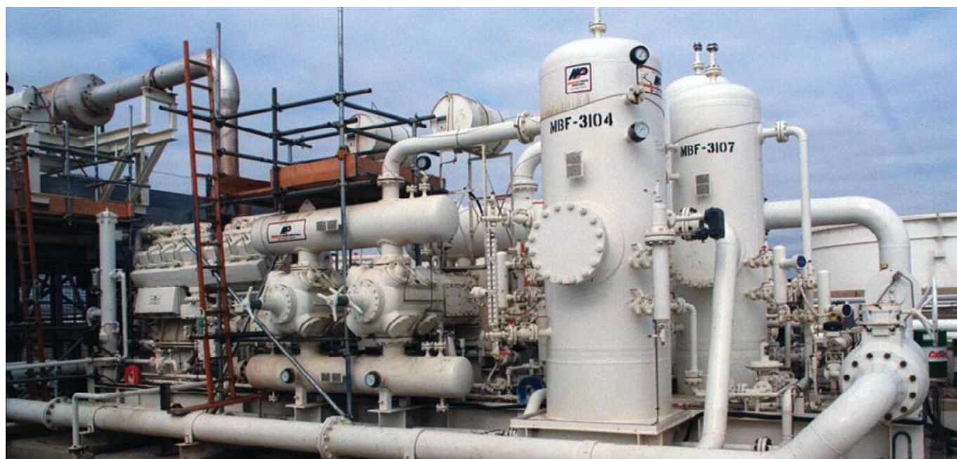
СП Амок, Баку, Азербайджан. КУ с компрессором Ариель JGD/4 и газовым двигателем 890 кВт.
