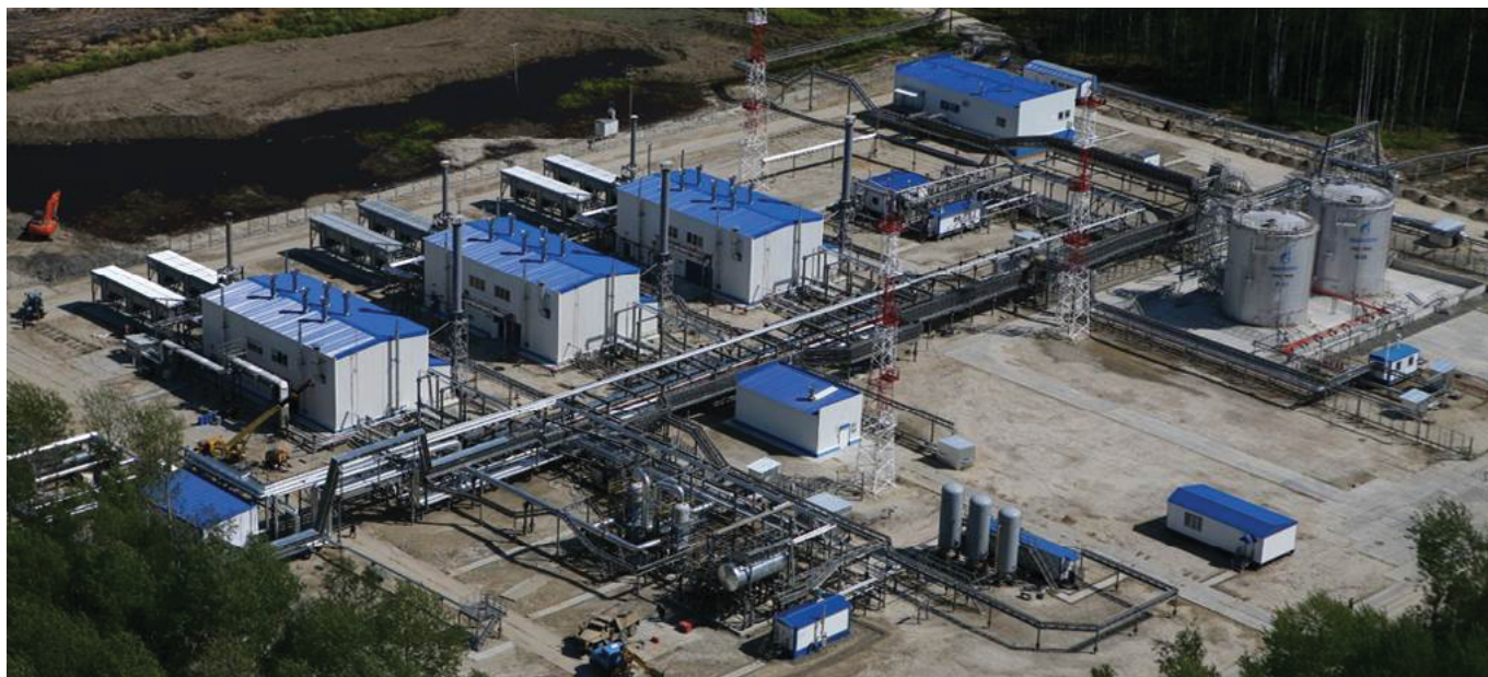
Томскгазпром, Казанская - 1. Три КУ с компрессорами Ариель JGZ/6-3 и приводом от газовых двигателей 3,6 МВт.
