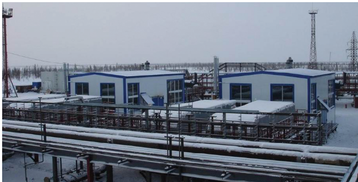
НОВАТЭК - ТАРКОСАЛЕНЕФТЕГАЗ. КУ с компрессорами Ариель JGC/6-2 с приводом от газовых двигателей 3,6 МВт.
