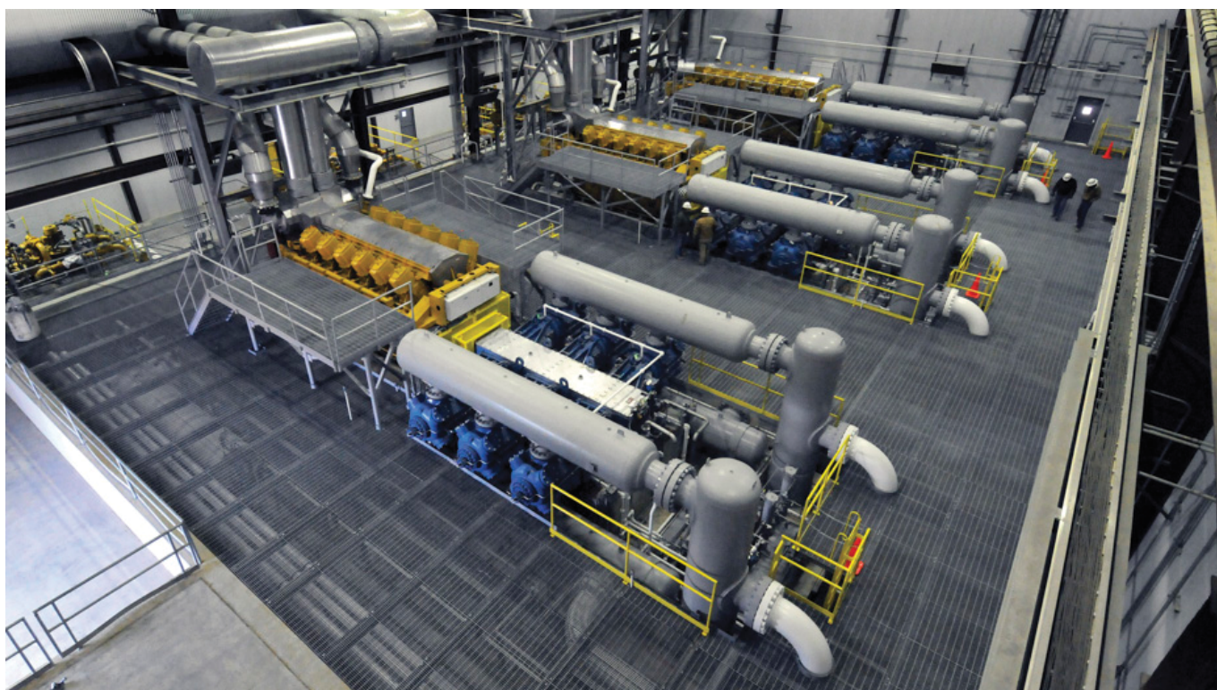
Газопровод REX в США. КУ с компрессорами KBU/6 и приводом от газового двигателя 6 МВт.
